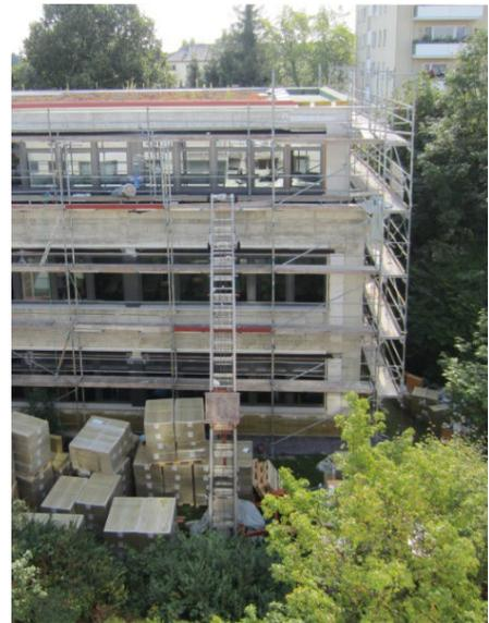
Die energetische Erhöhung der Gebäudehülle bildet zusammen mit der Erweiterung des Dachgeschoßes den zweiten Bauabschnitt. Holzfenster und asbesthaltige Plattenverkleidung werden durch Holz-Alu-Fenster und Wärmedämmverbundsystem gemäß ENEC 2019 ersetzt. Die Erneuerung der Terrassenabdichtungen und das bereits im 1. Bauabschnitt begrünte Flachdach vervollständigen die Außenhaut.
